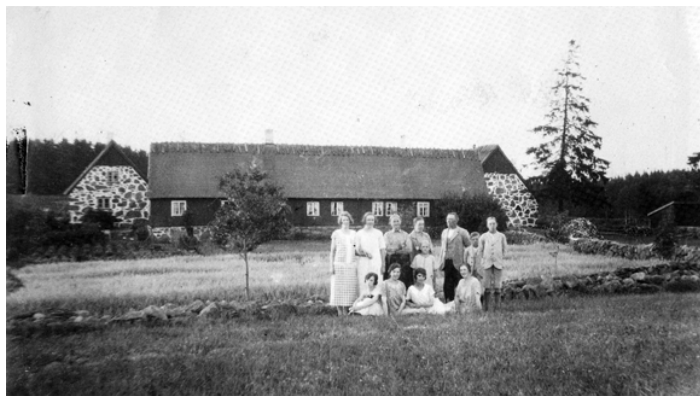
Bilden visar Grönhults bostadslänga från 1926 En brand på 2000-talet ödelade bostadslängan och den blev inte återuppbyggd
