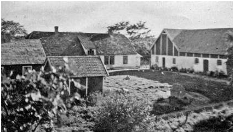
Stora Munkabo, Stenestad år 1943 Gert Ljungnérs föräldragård
